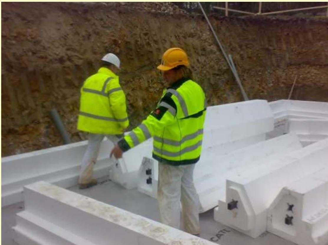
Randschalungmodule mit Rechteckrohr 40 x 60 mm
