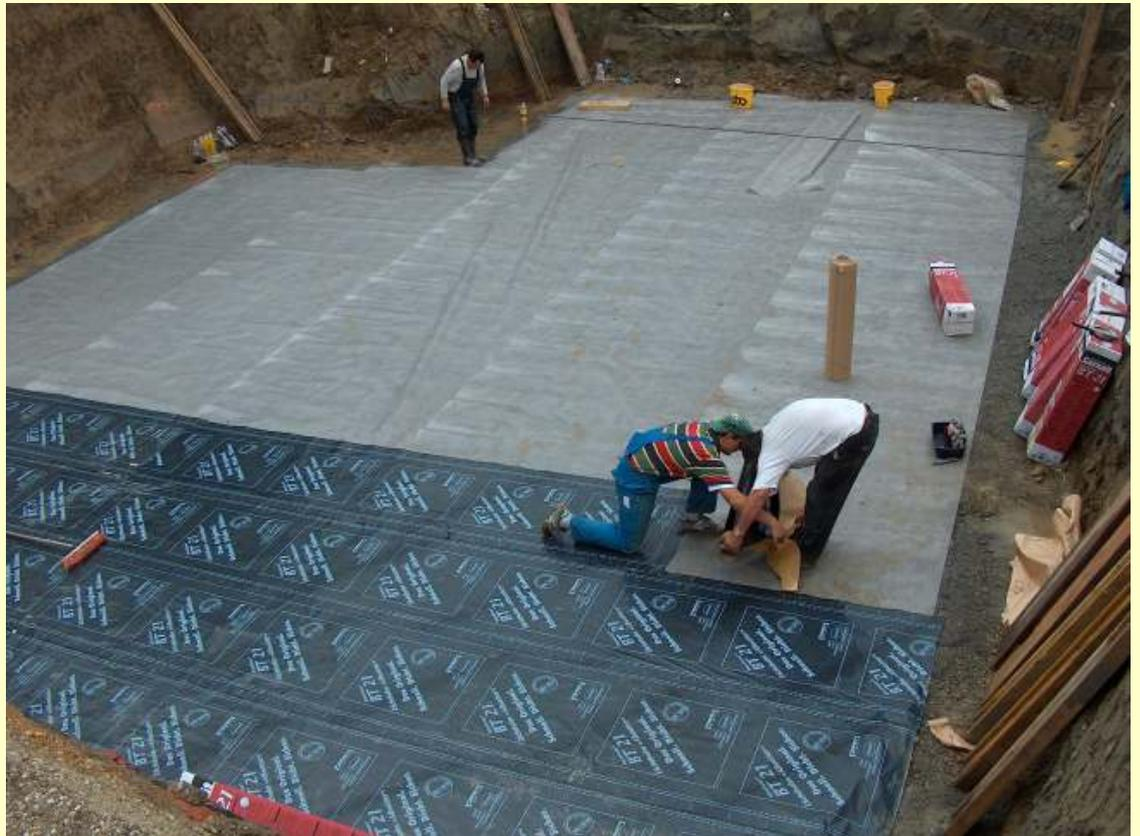
Beispiel: Dichtungsbahn (z.B. Bitumenkaltweißbahn) über Sauberkeitsschicht verlegen
